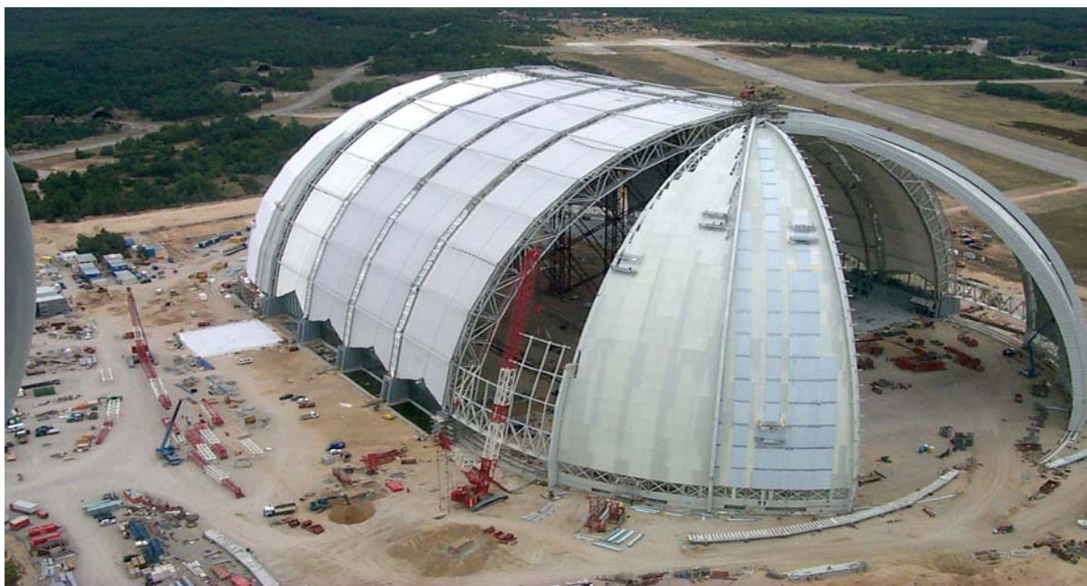
Bild 1 Hallenkonstruktion in der Bauphase
