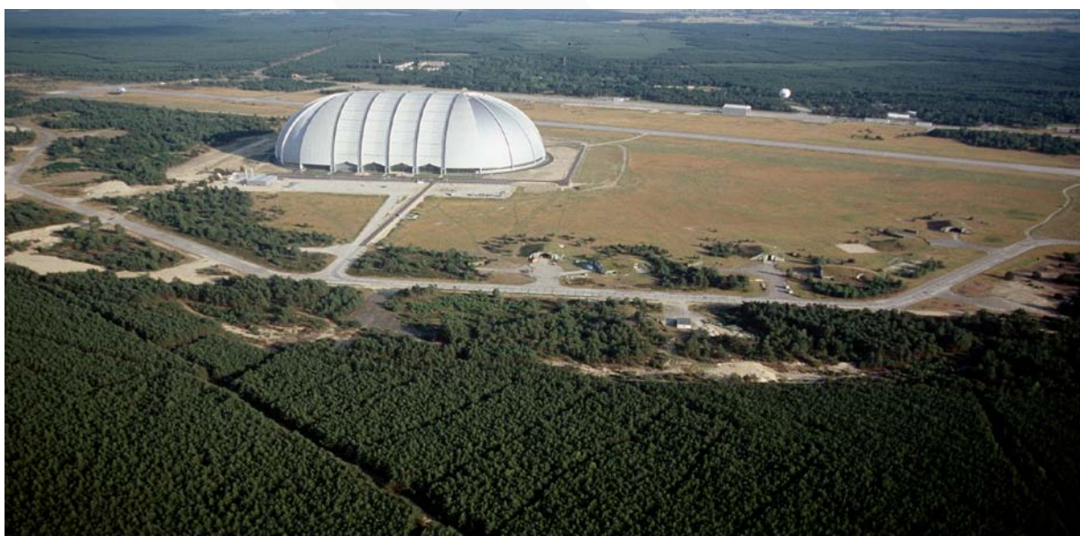
Bild 2 Außenansicht fertig gestellte Halle
